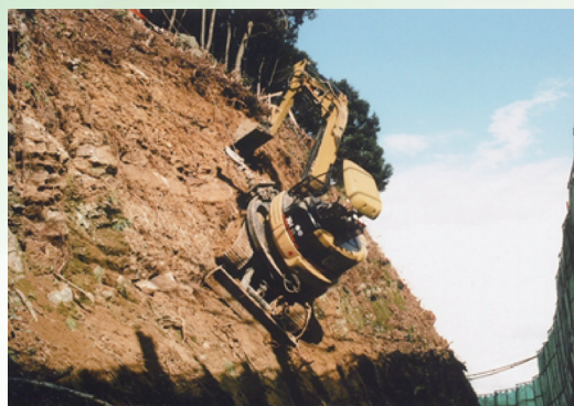
土砂・岩掘削
