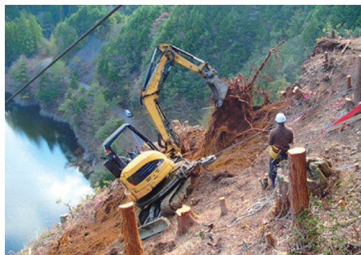
土砂掘削・根株処理
